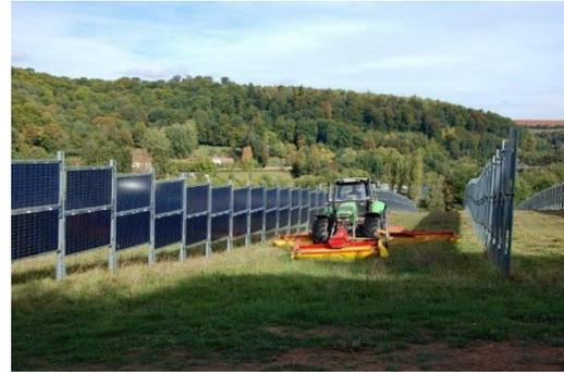
Abb. 2: Vertikale bifaciale PV Anlage (VBPV) im Saarland.
