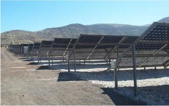
Abb. 1: Geneigte bifaciale PV Anlage in Chile.
